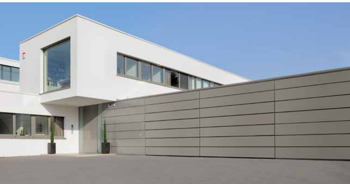
Opláštění hliníkovými spojovacími deskami na straně stavby
